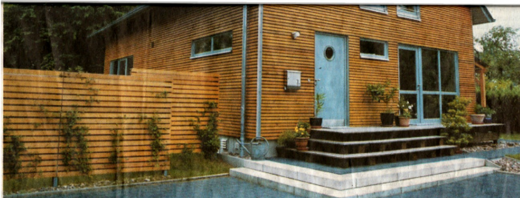
Einfamilienhaus. Ausgefeilte, moderne Haustechnik mit Wärmepumpe, Solarthermie, Belüftungsanlage und Regenwassernutzung kennzeichnet dieses Wohngebäude. Ein einfacher Grundriss und der Verzicht auf Vor- oder Rücksprünge der Fassaden sowie Gauben und Erker hielten die Baukosten dennoch im Rahmen.
